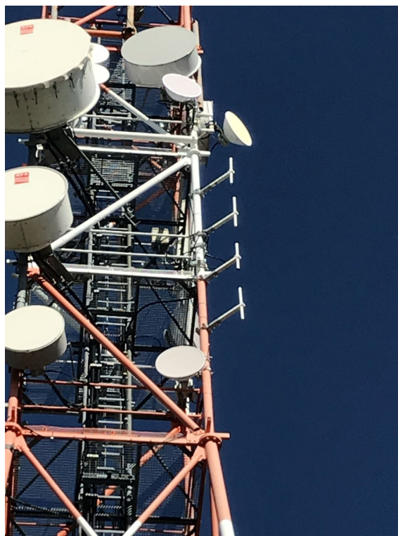
Obr. 7 – Vysielacie antény T-DAB+ na Panskom diele (pozn.: štyri zvislé tyče nad sebou na pravej strane obrázku)
