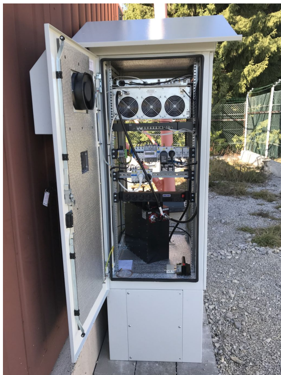
Obr. 6 – Skriňa na Panskom diele so zariadeniami T-DAB+
